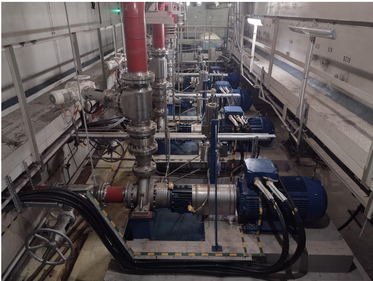
Rysunek 14. Pompy głównego układu chłodzenia kanałów paliwowych reaktora MARIA
