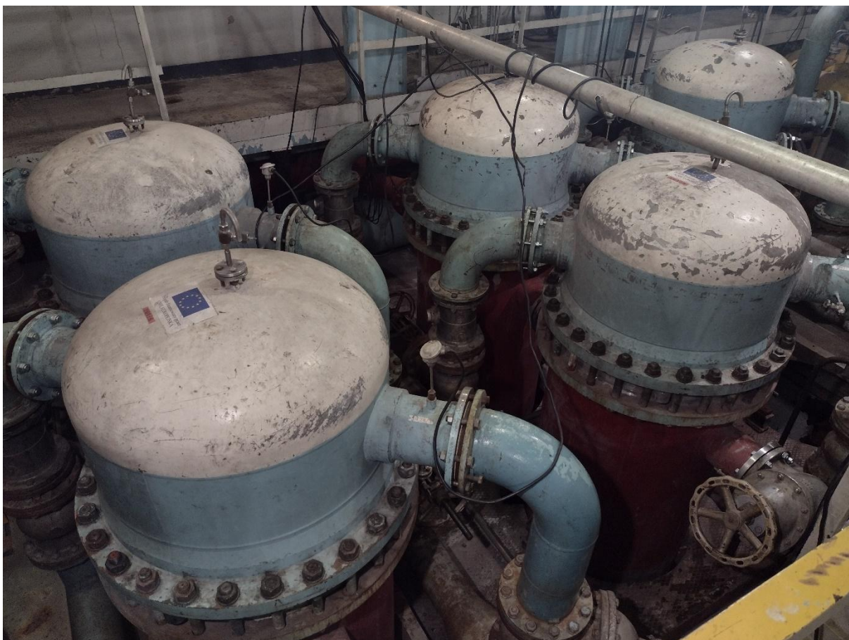
Rysunek 15. Wymienniki ciepła układu chłodzenia kanałów paliwowych reaktora MARIA
