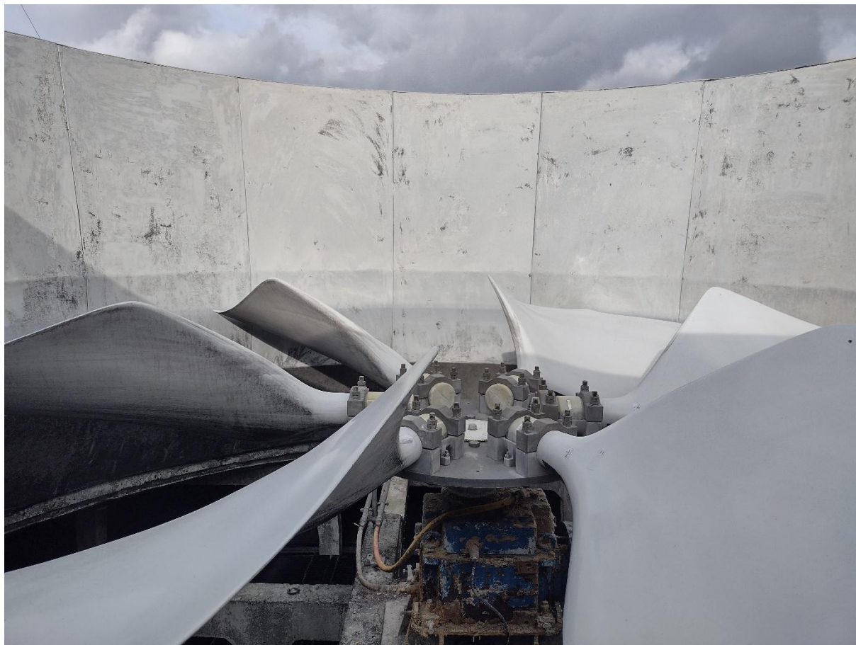
Rysunek 16. Wentylator chłodni wentylatorowej reaktora MARIA
